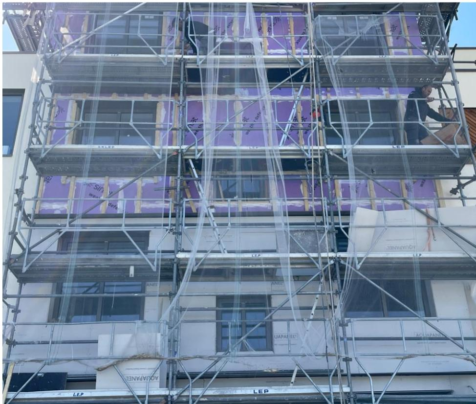
→ Pose de l'aquapanel et des déflecteurs de flamme
